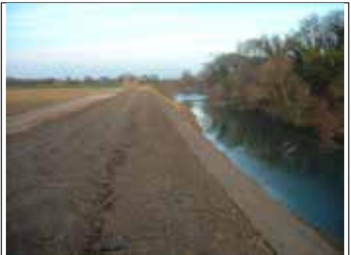
**19/03/2004 – Protection de surface. Mise en place du géotextile biodégradable sur la terre végétale avant enherbement**
