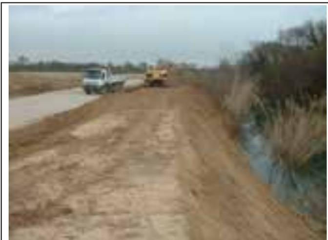
**27/02/2004 – Débroussaillage, réalisation des pistes et décapage du corps de digue.**
