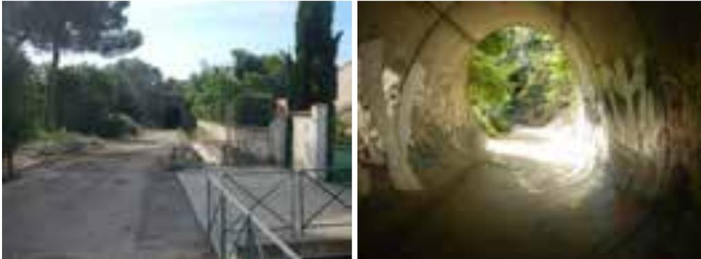
L'entonnement de cet ouvrage ne permet pas à la totalité des écoulements pluviaux arrivant par le chemin des Mimosas d'être évacué vers l'aval. A l'aval de l'ouvrage le lit du ruisseau de la plaine est très encombré ce qui ralentit l'évacuation des eaux. A noter une digue agricole en rive droite qui empêche les eaux de s'épandre en rive droite.
