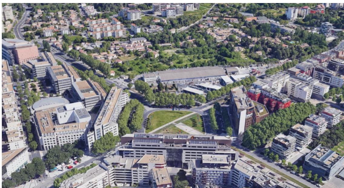
Vue aérienne de la place Ernest Granier
