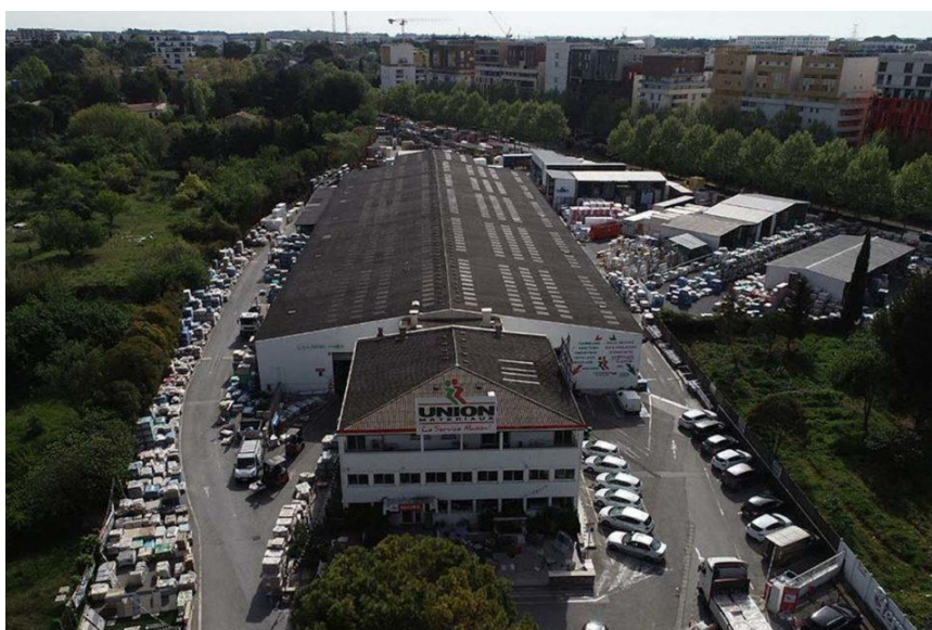
Vue aérienne de l'entrepôt de matériaux
