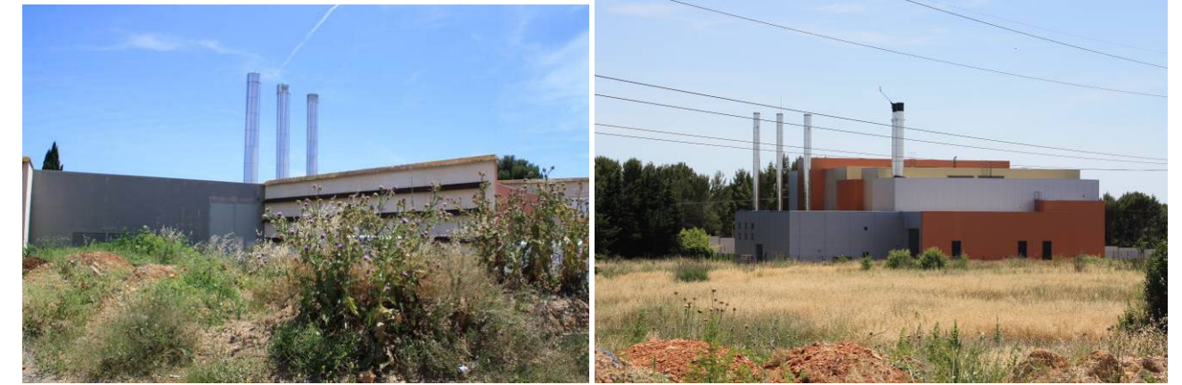
Les deux centrales thermofrigorifiques
