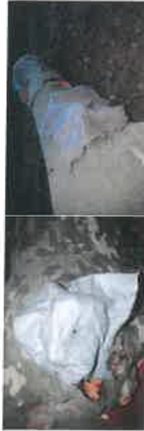
Illustrations de dispositifs d'obturation mise en place (MONTPELLIER)
