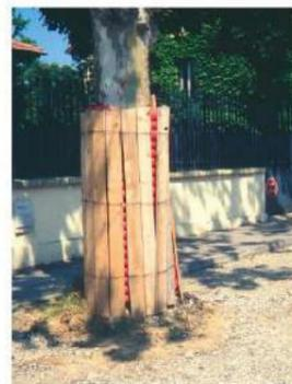
**EXEMPLE DE DISPOSITIF PERMETTANT DE PRESERVER LES TRONCS DES ARBRES (SOURCE : FICHE PRATIQUE « PROTECTION DES ARBRES SUR CHANTIER », 2008, GRAND LYON COMMUNAUTE URBAINE)**
