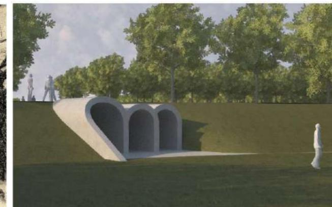
Réinterprétation dans des formes plus sinueuses, de l'arche romaine pour les têtes des ouvrages de régulation de l'eau au Parc Montcalm
