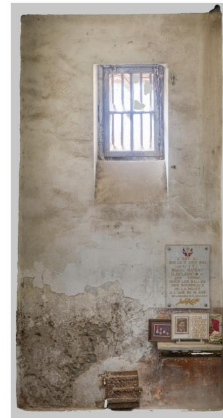
Élévation intérieure de la cellule 03 située côté droit. Elle fut occupée par Raoul Botany décapité le 17 août 1944.
